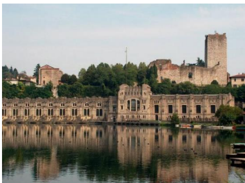
La centrale Taccani
